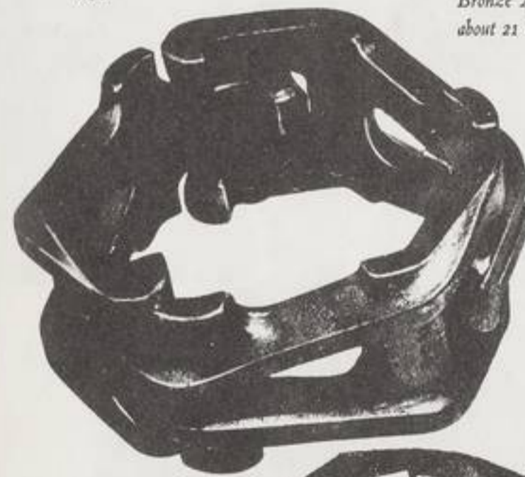
75. dreiteiligen Ringelements, das jeden räumlichen Standardknotenpunkt der Stahlrohrhallenkonstruktion zusammenschließt (Foto Aaron Siskind)
